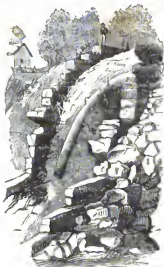
Fig. 53. — Natural steps sul fiume Arkansas.
